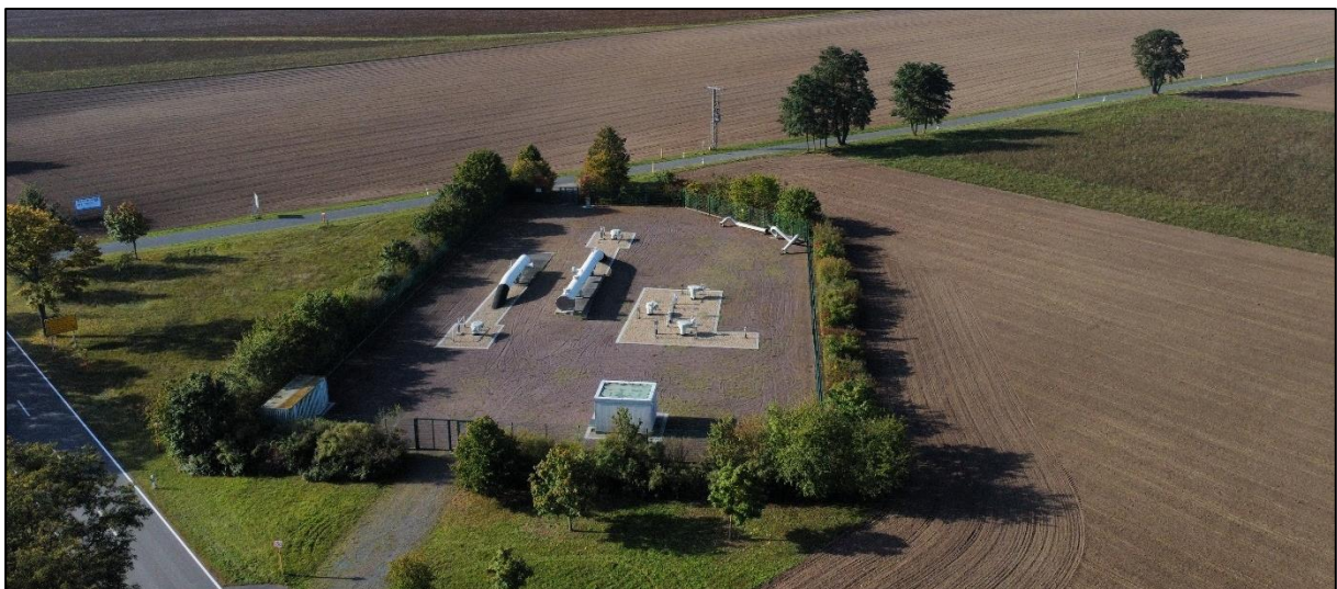
Abb. 5 Teilfläche A: Molchstation südöstlich des Plangebiets (Foto: BÜRO KNOBLICH GMBH 2023)
