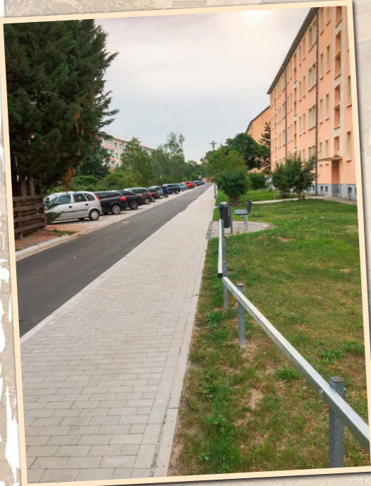
Straße der Freundschaft mit Fördermitteln saniert
